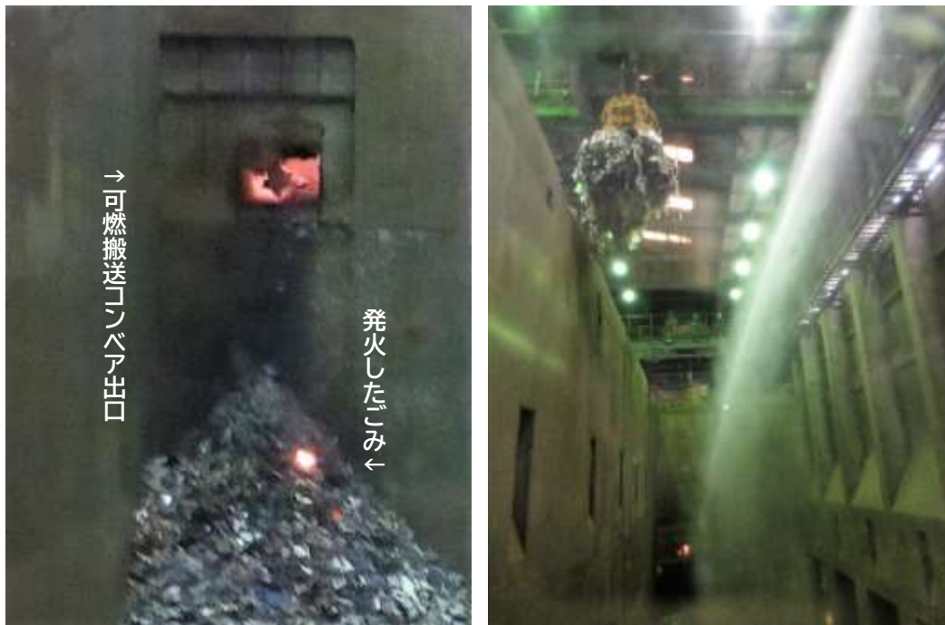
発火確認後、直ちに放水銃で発火部分に放水し、消火にあたっている様子（8月5日）
