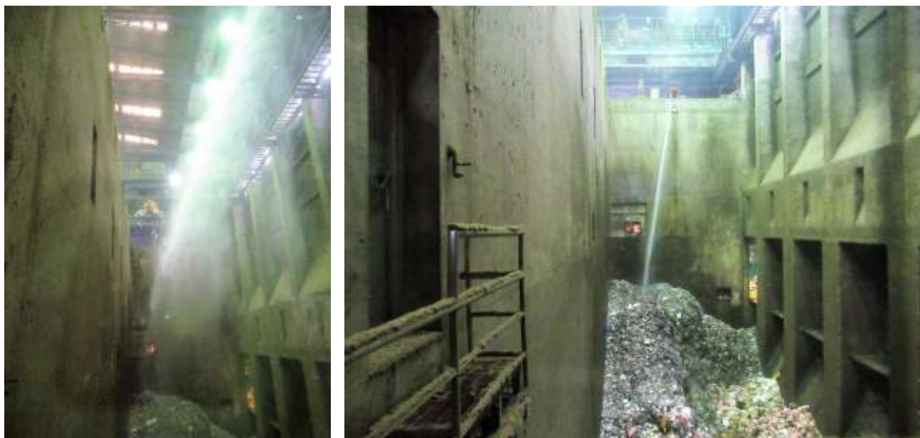
消火している様子（5月13日）
