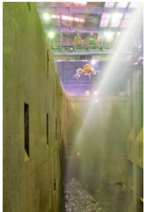
放水銃で消火している様子(2月15日)
